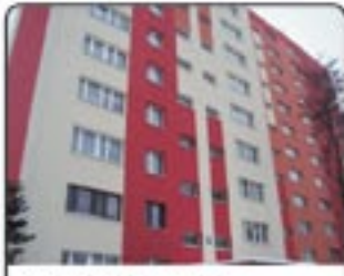
Zabrze Franciszkańska - mieszkanie 2 pokojowe na 11 piętrze. Po remoncie. Pow. 49,20 m 2 . Pokój z balkonem. CENA 112.500 zł
