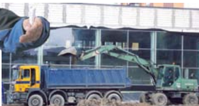
Aktualnie powstają parkingi i drogi wokół pływalni
