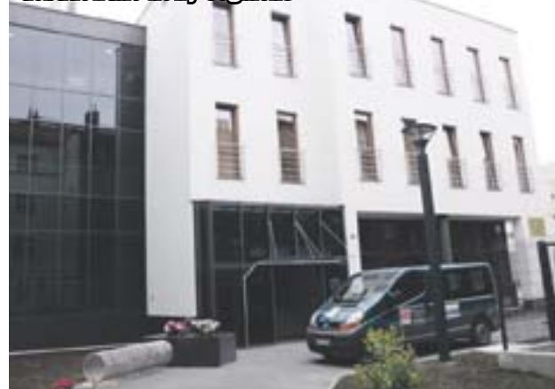
Do gmachu dawnej szkoły dobudowano nowy segment
