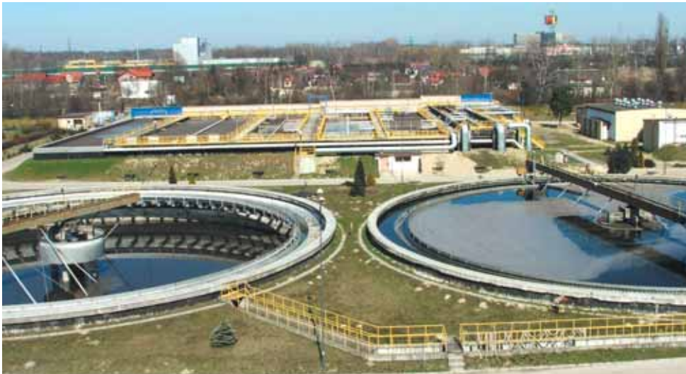
Dzięki unijnym dotacjom, Zabrze posiada jedną z najnowocześniejszych oczyszczalni ścieków w Europie. Oczyszczalnia „Śródmieście” jest jednym z pięciu przedsięwzięć, budowlanych realizowanych w ramach programu modernizacji wodociągów i kanalizacji.
