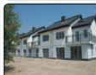
Okolice Gliwic - zakończona inwestycja domów szeregowych. 3 kilometry od węzła A-4. Domy o pow 179m i 193m. Cena od: 530.000 zł
