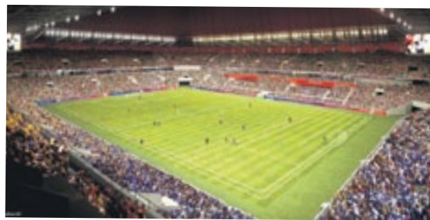
We wrześniu rozpoczęła się przebudowa stadionu miejskiego
