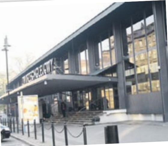
Wyremontowany w tym roku budynek dworca kolejowego
