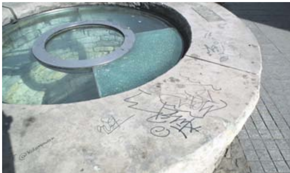
Kompletnie zdezastrowana studnia miejska. Idiotoodporna nie była nawet szyba z grubego szkła. Nie wytrzymało też obramowanie, w wielu miejscach ukruszone.
